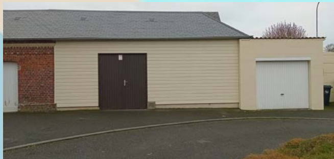
Peinture extérieure local communal
